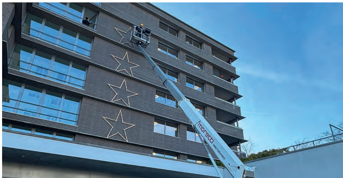
Mit der Hebebühne werden die riesigen Holzsterne an der Gebäudefassade montiert. Bilder: zvg
