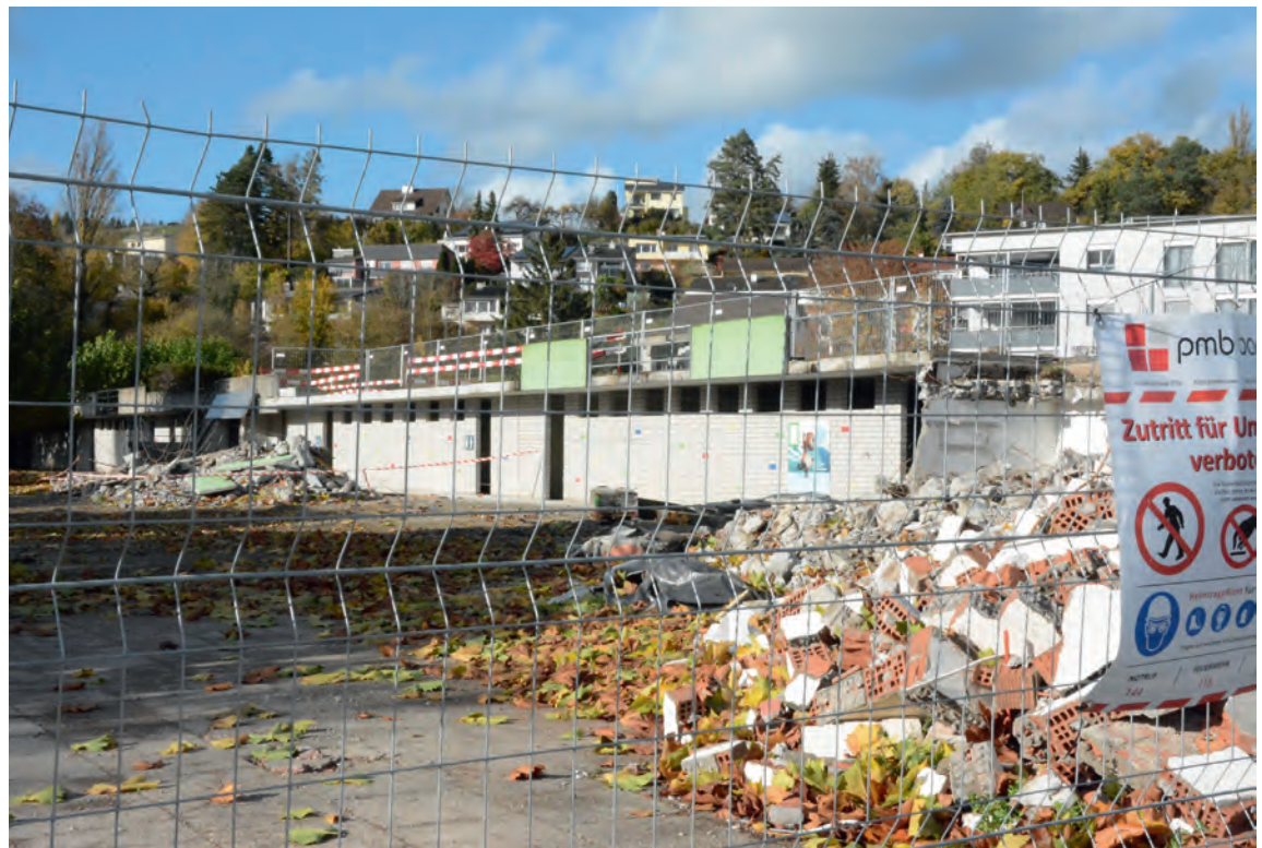
Verwaiste Baustelle mit zum Teil in Angriff genommenen Abrissarbeiten. Bild: vf
