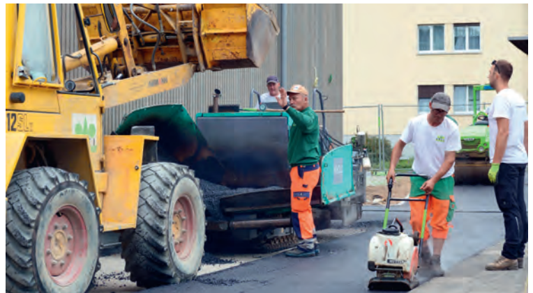
Die Bauarbeiten neigen sich dem Ende zu – Zeit- und Finanzplan konnten eingehalten werden. Bilder: Rolf Fehlmann
