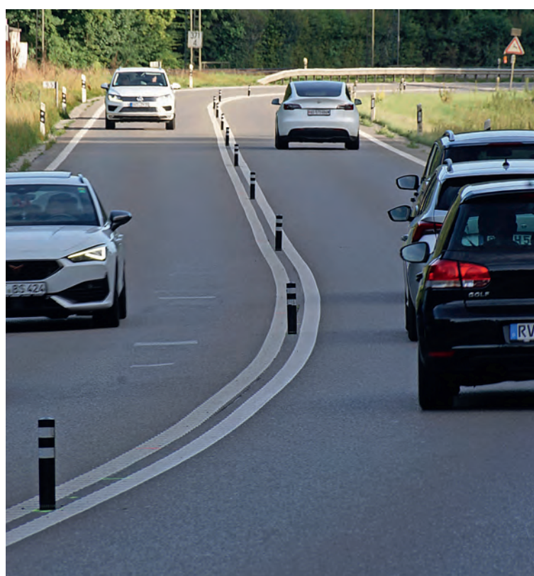
Mit Leitboy-Pollern abgetrennte A4-Fahrbahnen. Bild: vf
