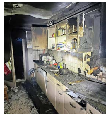
Die beschädigte Küche. Bild: zvg
