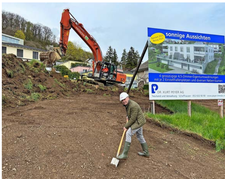
Bauherr Peter Kunz, dahinter Baggerfahrer Markus Grieder.
