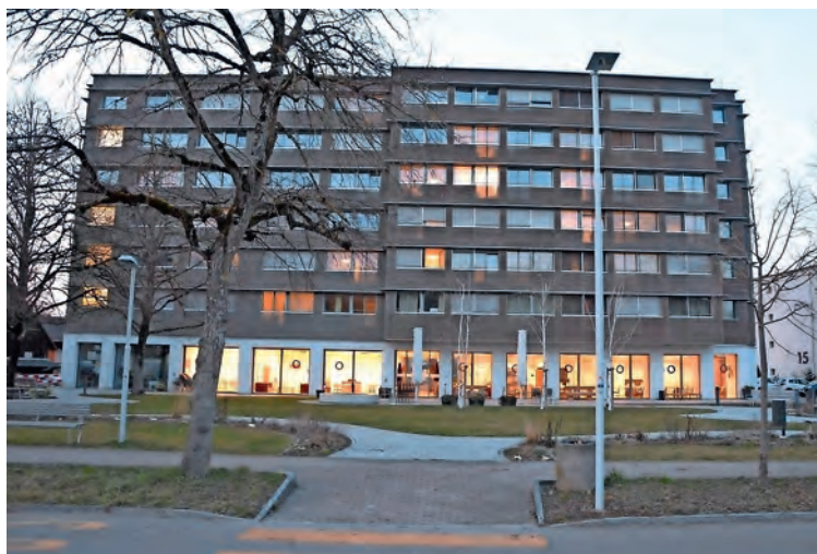
Das Seniorenzentrum Im Reiat (SIR) wurde nach vierjähriger Bauzeit im Mai 2019 offiziell eingeweiht. Archivbild: vf
