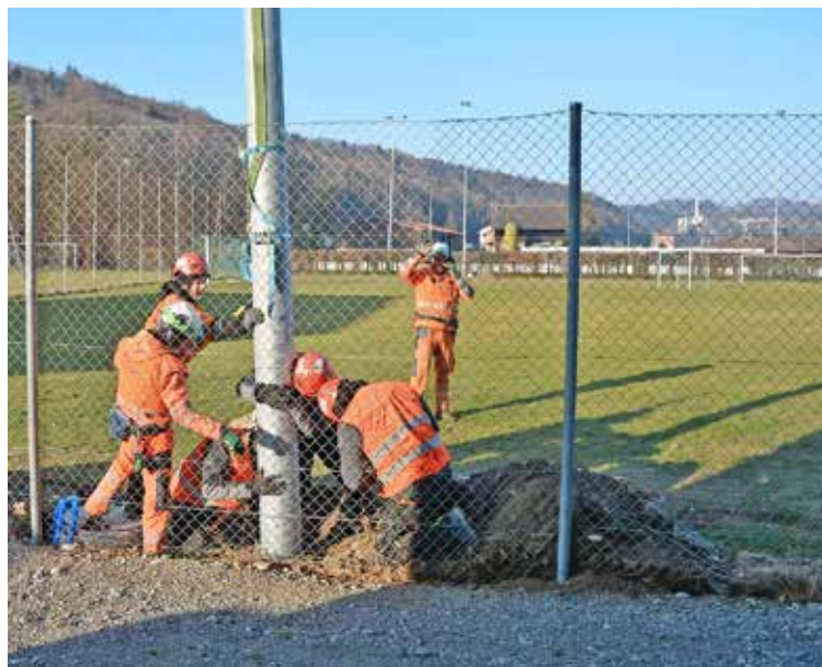
Noch hängt der Lichtmast am Helikopterseil. Ein sechsköpfiges Team führt die schwebende Fracht zum vorbereiteten Loch im Boden. Der Mann rechts, stehend, ist im Funkkontakt mit dem Piloten. Bilder: vf
