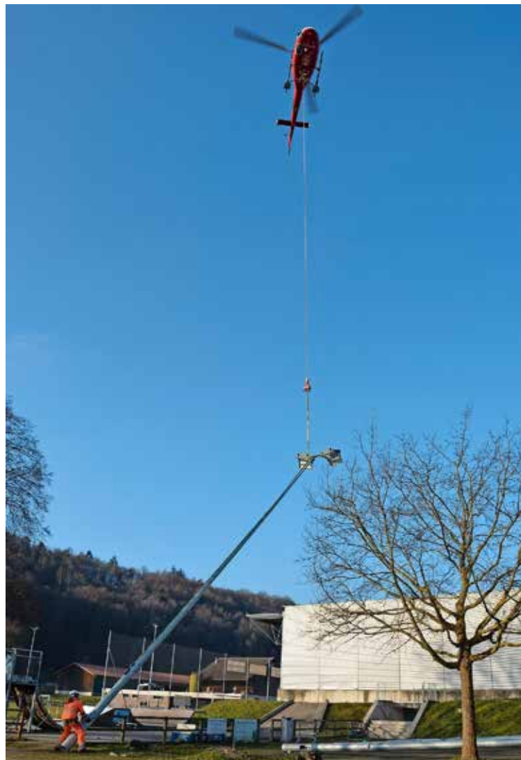
Die Flutlichtmasten liegen neben der Stockwiesenhalle bereit. Der Helikopter bringt einen nach dem anderen auf die Sportplätze. Bild: vf
