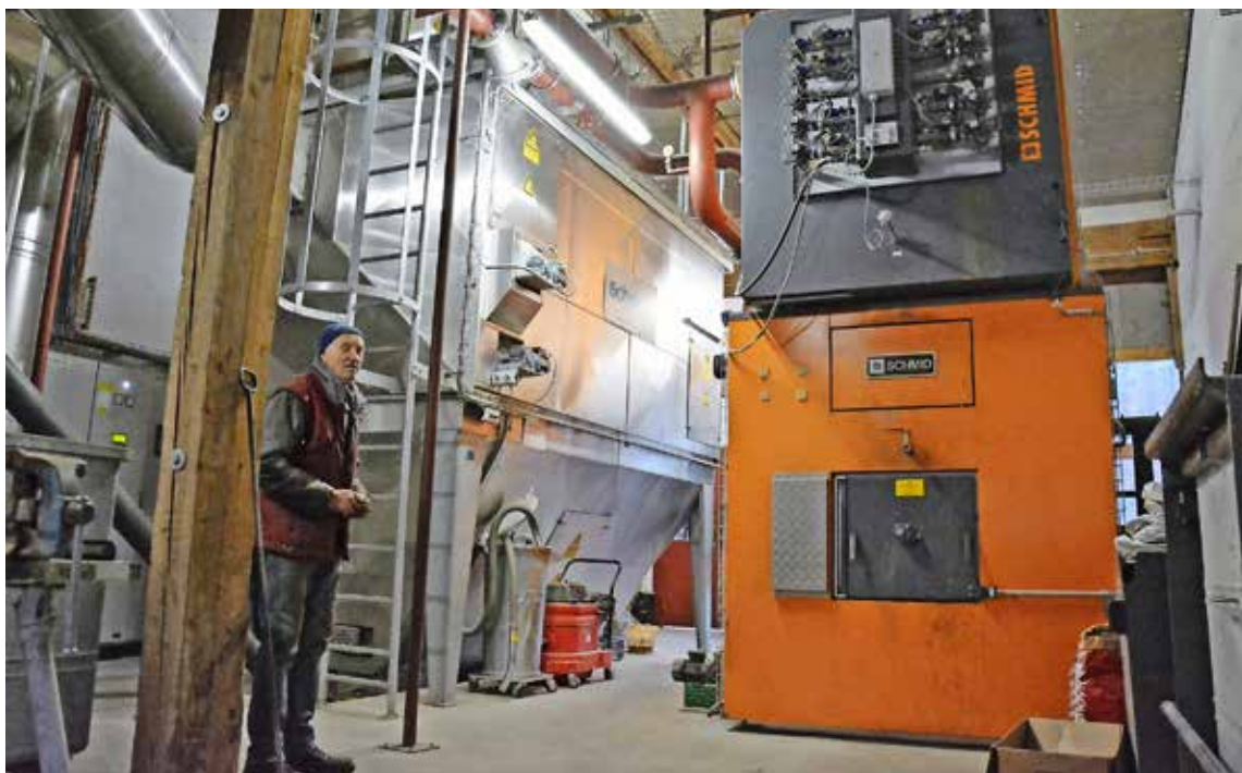
Wärme aus nachwachsenden Rohstoffen: Der orangefarbene Kasten ist einer von drei Holzschnitzel-Heizkeseln des Wärmeverbunds der A. & M. Winzeler GmbH. Im silbrigen Ungetüm daneben werden die Rauchgase gefiltert. Auf dem Bild: Seniorlandwirt Hansjakob Winzeler. Bild: vf
