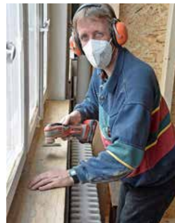
Stefan Bösch schleift ein Fensterbrett – mit Maske gegen Staub.
