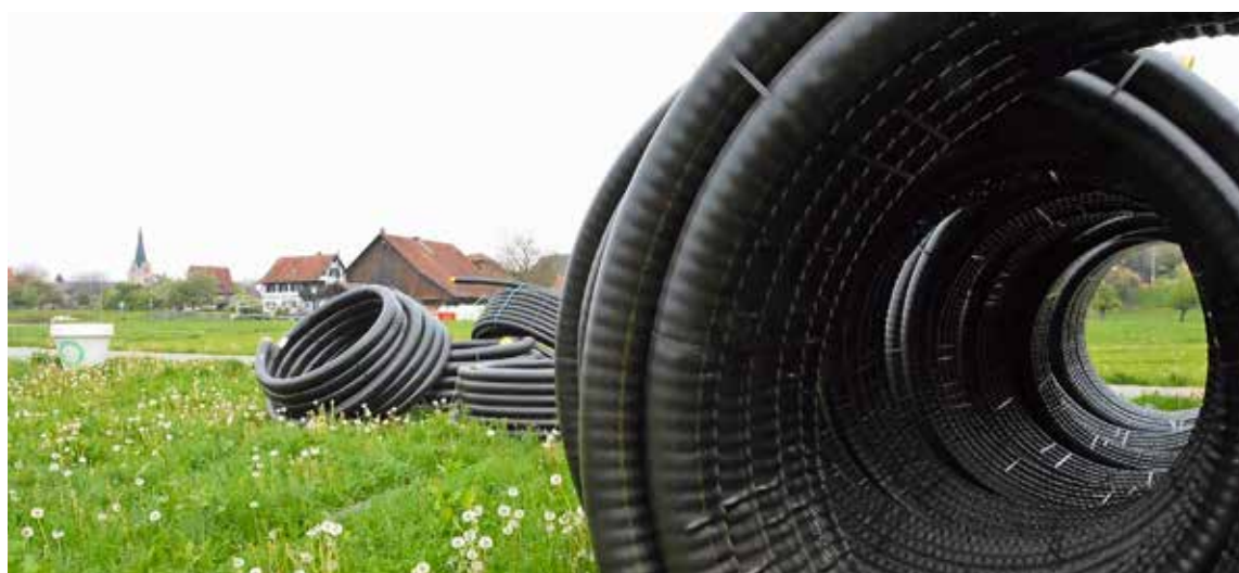
Beim Friedhof warten aufgerollte Fernwärmeleitungen darauf, in den Boden verlegt zu werden. Bild: vf
