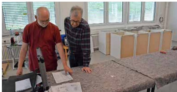
Walter Gfeller (links) und André Richoz sind daran, die Küchenmöbel (rechts) zusammenzusetzen. Sie studieren die Montageanleitung.
