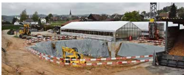
Bauarbeiten auf dem Gewächshausareal der Familie Schalch. Bild: vf
