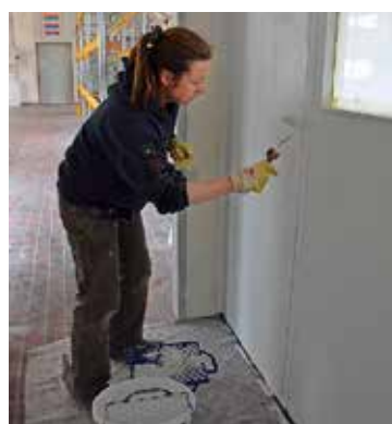
Judith Däumigen streicht eine Wand mit Farbe.
