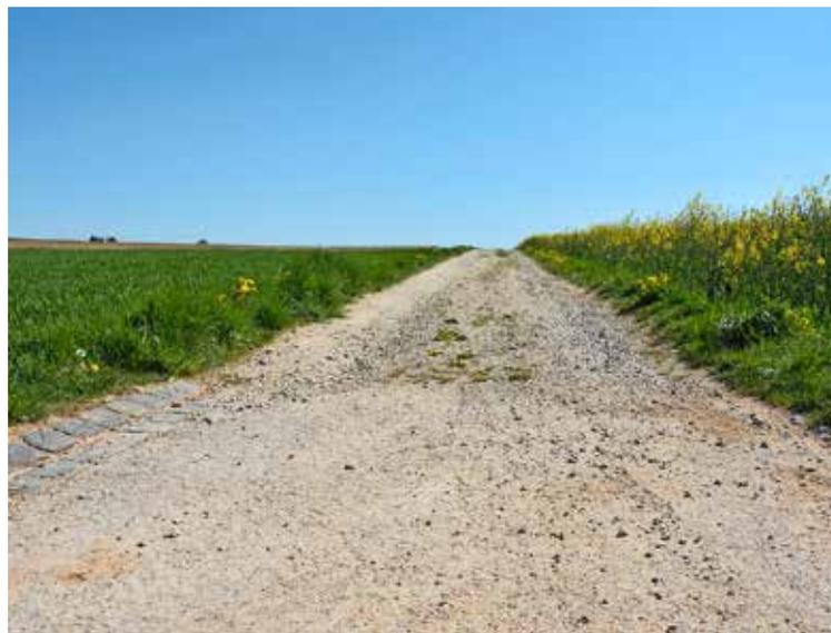
Feldweg zwischen Thayngen und Barzheim. Damit er befahrbar bleibt, muss er regelmässig unterhalten werden. So müssen unter anderem der Belag gekiest, Löcher geflickt und die Erde links und rechts entfernt werden. Bild: vf
