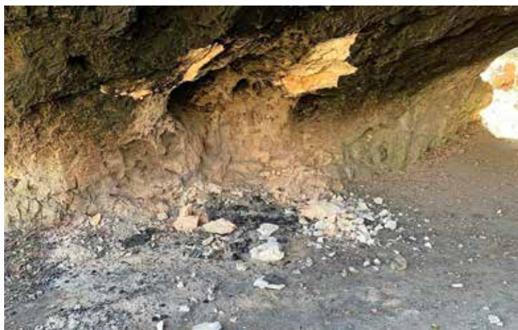
Ein entfachtes Feuer hat die Höhlendecke beschädigt. Bild: zvg
