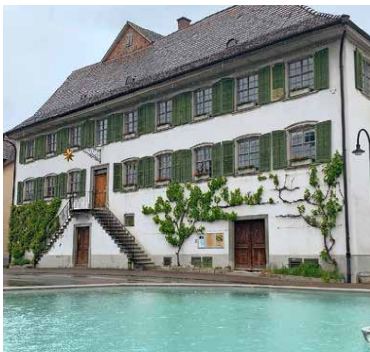
«Flüssige Mittel» gibt es nur im Brunnen vor dem «Sternen». Für den Umbau der historischen Liegenschaft reichen sie nicht. Bild: Paul Ryf, Thayngen
