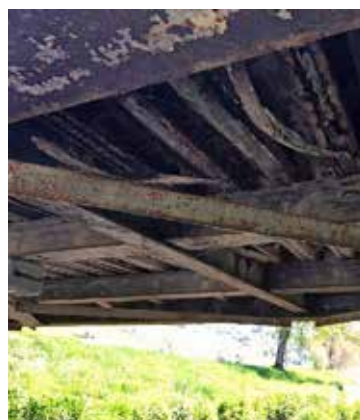
Ein Blick unter die alte Brücke zeigt die Schäden. Bild: Christian Müller
