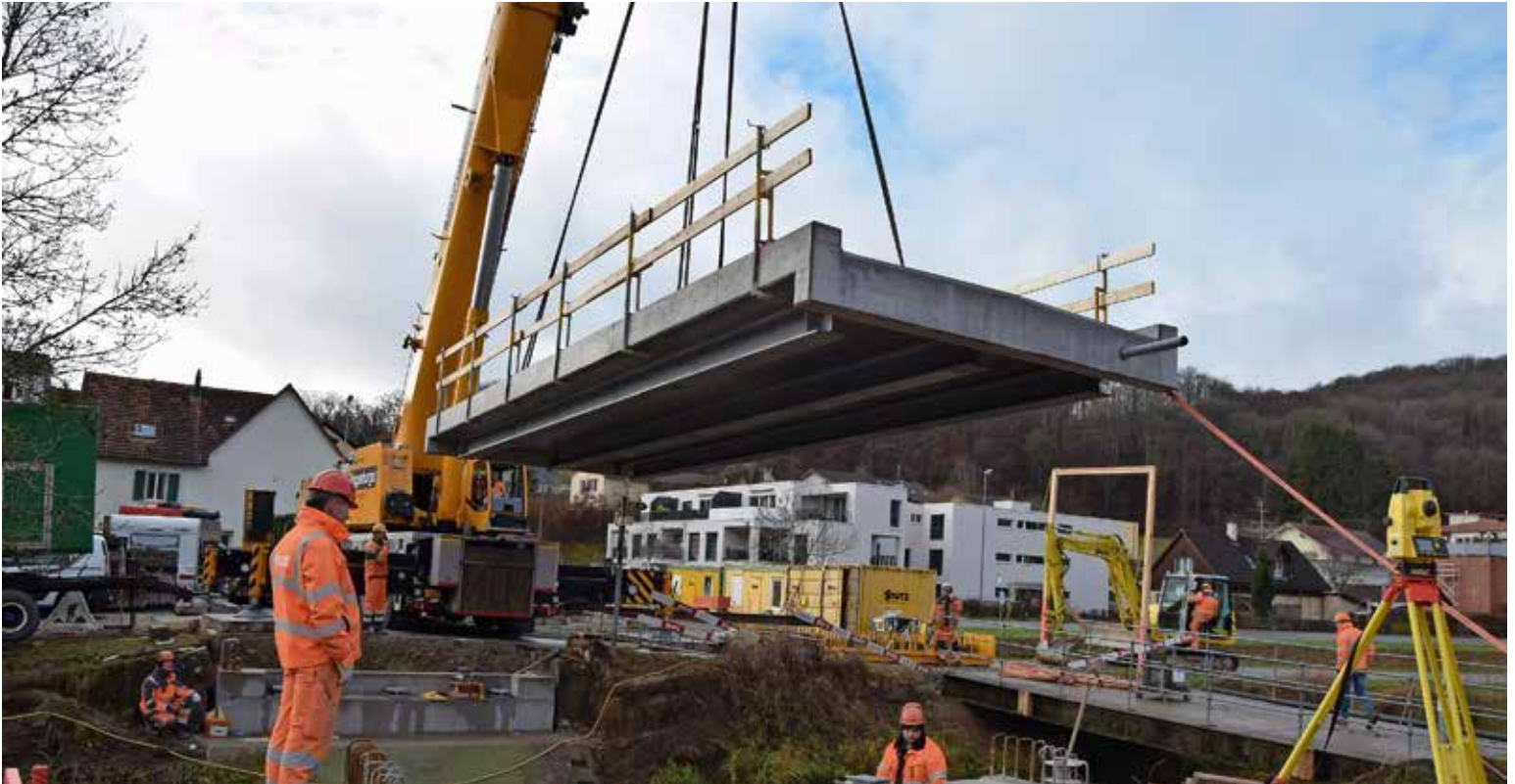
Ein Spezialkran transportierte das 45 Tonnen schwere Fertigelement am Donnerstagvormittag an Ort und Stelle. Bilder: Franziska Bartel
