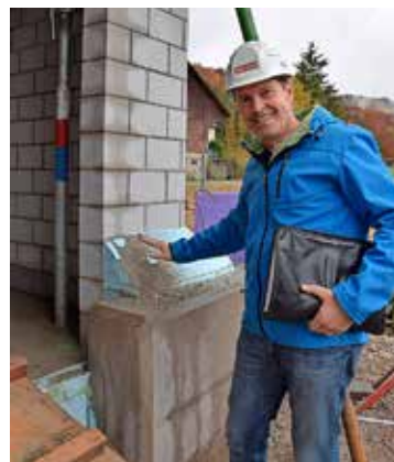
Über dem Betonsockel werden noch die Klinker angebracht.
