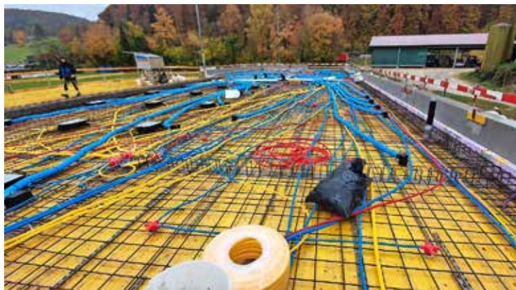
Das Dach vor der Betonierung: Zu sehen sind die Unterarmierung und die Leitungen für Lüftung, Sanitär und Elektrik. Bild: Peter Marti
