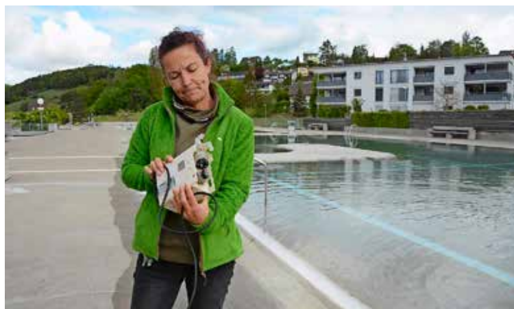
Die Bademeisterversantwortliche Tanja Schneider begutachtet eine Pumpe, die letzte Woche gestreikt hat. Bilder: vf
