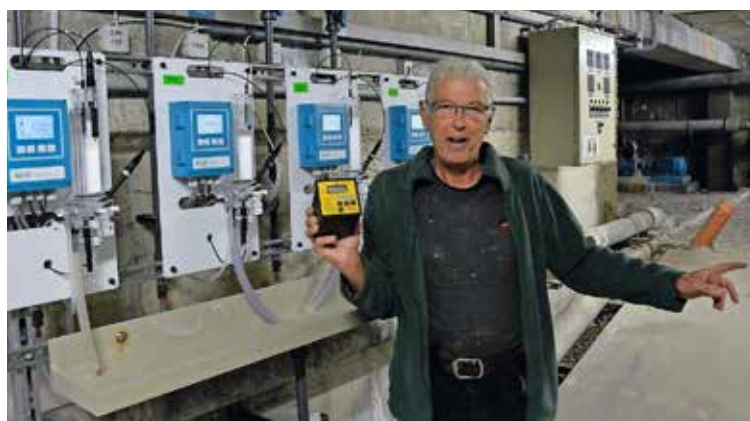
Um das Bad betreiben zu können, mussten vor Saisonbeginn die vier blauen Messzellen im Hintergrund installiert werden. Bademeister Aschi Bremer hält eines der Vorgängermodelle in der Hand.
