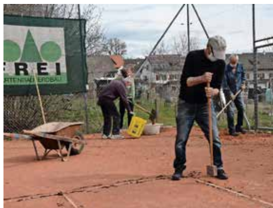
Der frühere Platzwart Erwin Ehrat drückt die Kunststoffmarkierungen mit einem Werkzeug flach.
