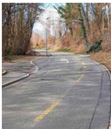
Blick in Richtung Schlatt: Die Verkehrsinsel (Mitte) mit dem neu erstellten Trottoir (vorne links).
