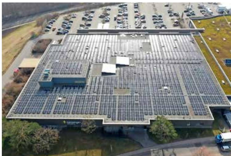
Mit dem Strom der neuen Fotovoltaikanlage können Jahr für Jahr rund 62 Tonnen CO 2 eingespart werden. Bild: zvg
