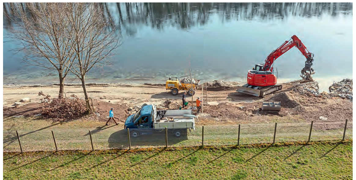
Die letzten Arbeiten vor dem Abschluss der für das laufende Jahr geplante Renaturierung. Bild: zvg
