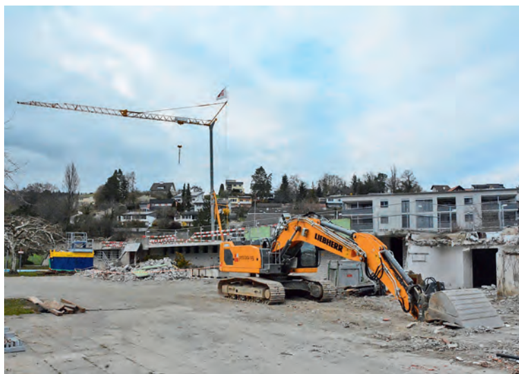
Die Baumaschinen sind zurück, die Abrissarbeiten gehen weiter. Bild: vf
