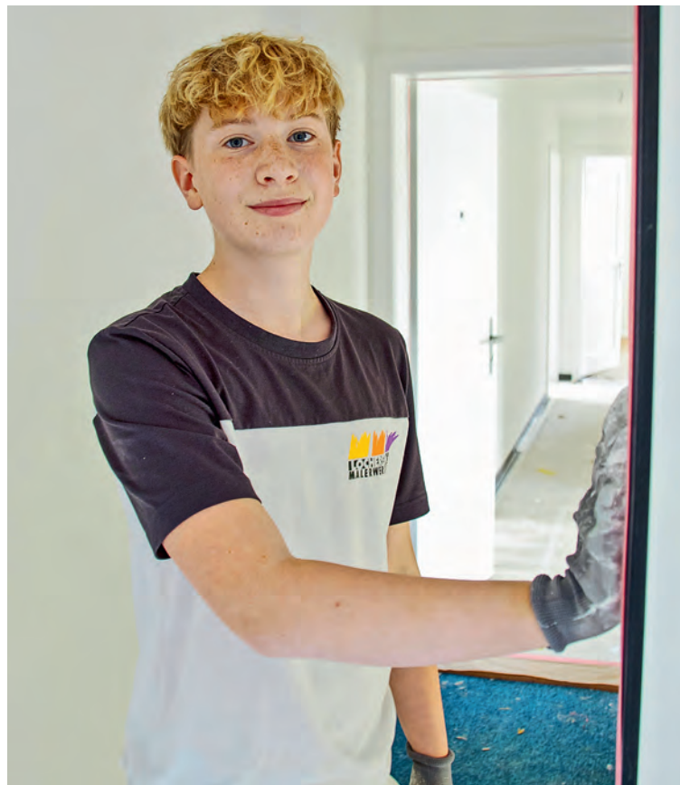
Der Auszubildende Levi Kläui schleift in einem Umbau die alten Türrahmen an. Bild: zvg
