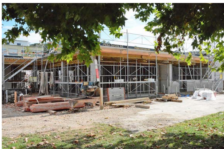
Das zukünftige Restaurant im Erdgeschoss ist bereits weit fortgeschritten. In der Mitte ist der Bereich zu sehen, wo die Gäste der-einst sitzen werden. Rechts wird man den Eintritt ins Schwimmbad lösen.
