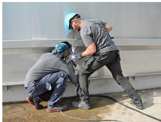
Zwei Fachmänner verschweissen die Bleche des Schwimmerbeckens.
