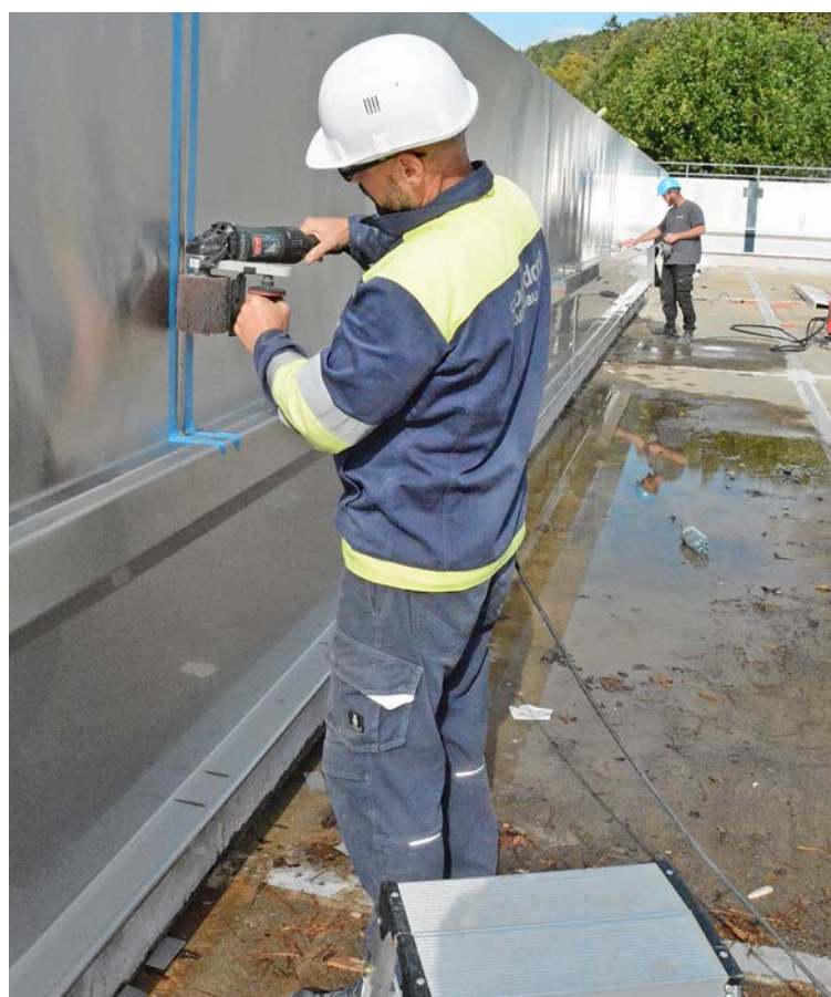
Ein Fachmann bearbeitet im Schwimmbereich eine Schweißnaht der neuen Stahlhülle. Noch ist der frühere Betonboden zu sehen. Bild: vf
