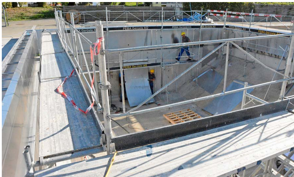
Im Sprungbecken platzieren Arbeiter rostfreie Stahlbleche. Bilder: vf
