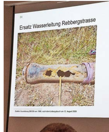
Die gebrochene Wasserleitung an der Rebbergstrasse. Bild: gb
