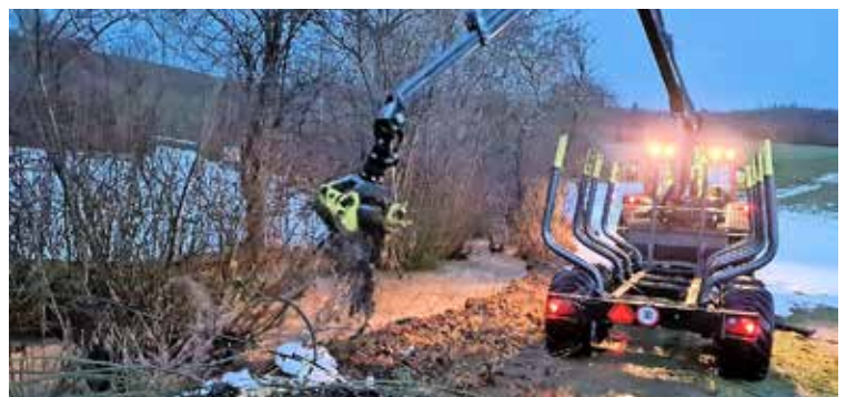
Entfernen von Holz mit Forstgerät der Gemeinde Thayngen aus dem Aalterfermbächli, um den Geschiebe-Aufstau zu eliminieren.
