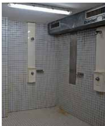
Ein Duschraum für alle – und das ohne funktionierende Lüftung.
