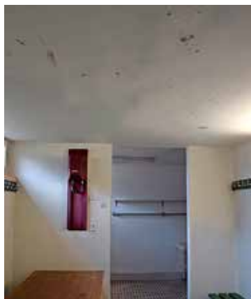
Der Schimmel an den Decken bildet sich immer wieder. Bilder: fb
