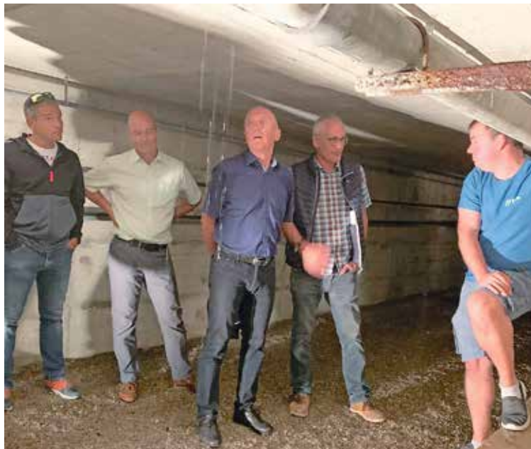
Rundgang im Untergrund des Schwimmbads Büte. Aus Leitungen und Betondecken tropft überall das Wasser. Bild: vf
