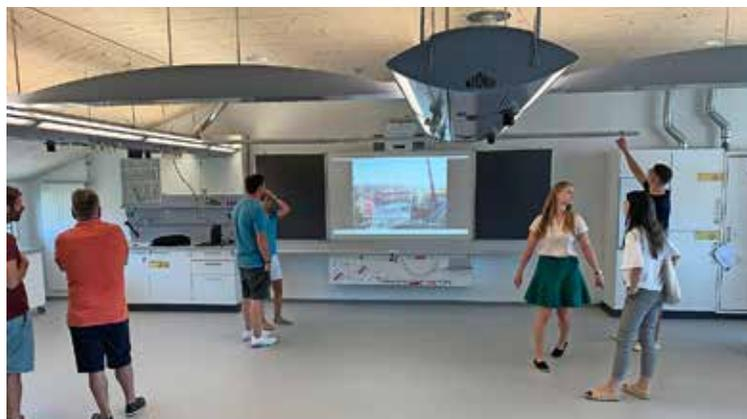
Das Zimmer für Natur und Technik (N+T): An den Deckenleisten (links und Mitte) hat es Wasser- und Gasanschlüsse für mobile Arbeitsplätze.
