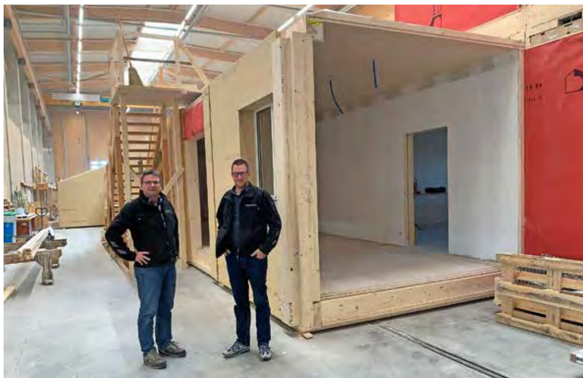
Bauleiter Hanspeter Fehr (l.) und Planer Philipp Bernhard vor dem neuen Stockwerk des Reckenschulhauses. Rechts von ihnen ist der Flur zu sehen. Die Türöffnung führt in eines der Klassenzimmer. Bild: vf
