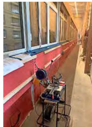
Die Südseite des Schulhausaufbaus. Bilder: vf
